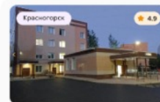
Красногорская больница 143400, Московская область, г. Красногорск, ул. Карбышева, д. 2
